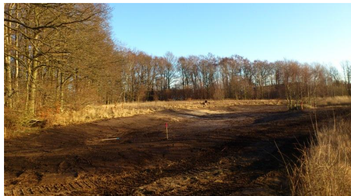
Just nu pågår arbetet med att anlägga våtmarkerna.
